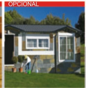
Panel sandwich en el exterior de espesor superior a 6cm compuesto por 2 láminas de acero galvanizado lacado con interior de espuma de poliuretano de alta densidad recubiertas por revestimiento exterior pétreo de gran calidad mate e hidrófugo. (zócalos y esquinas en piedra natural)
